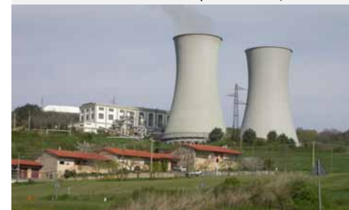
Centrale geotermica di Castelnuovo Val di Cecina, nell'alto bacino del Torrente Pavone (foto L. Lombardi, archivio NEMO)
