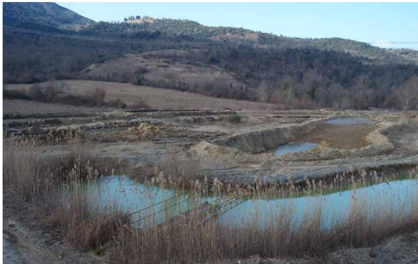
Cava presso il ponte di Monteguidi in area di pertinenza fluviale del Fiume Cecina: vasche di decantazione dei fanghi di lavaggio del materiale alluvionale (foto L. Lombardi, archivio NEMO)
